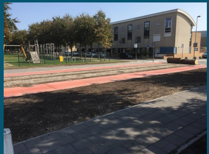
Afbeelding 4.1: Voorbeelden van onderhoudsprojecten waarbij rekening wordt gehouden met klimaatadaptatie, door het toepassen van halfverharde parkeerplaatsen (boven) of het weglaten van verharding.
