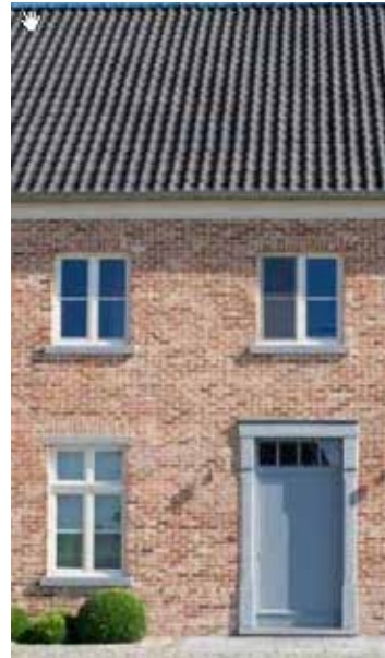
Nuances in kleurenpalet van bakstenen gevels
