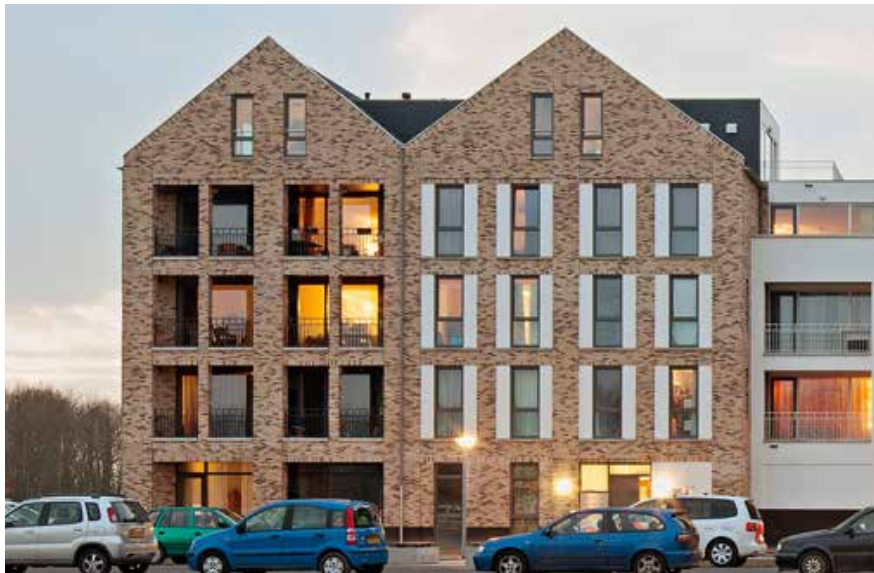
Afwisseling door verschillen in ritmiek in de gevelwand
