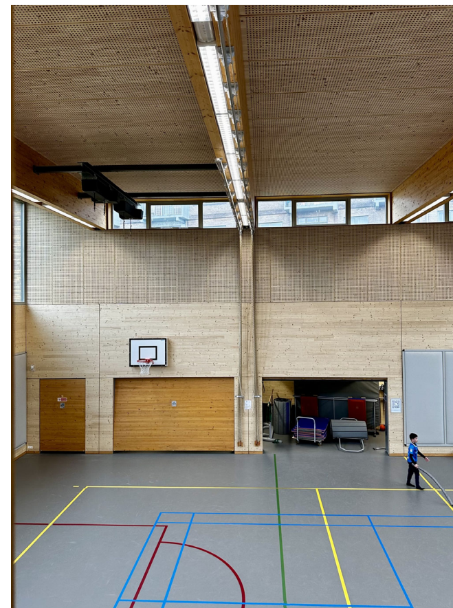
houten wanden /balken en plafond
