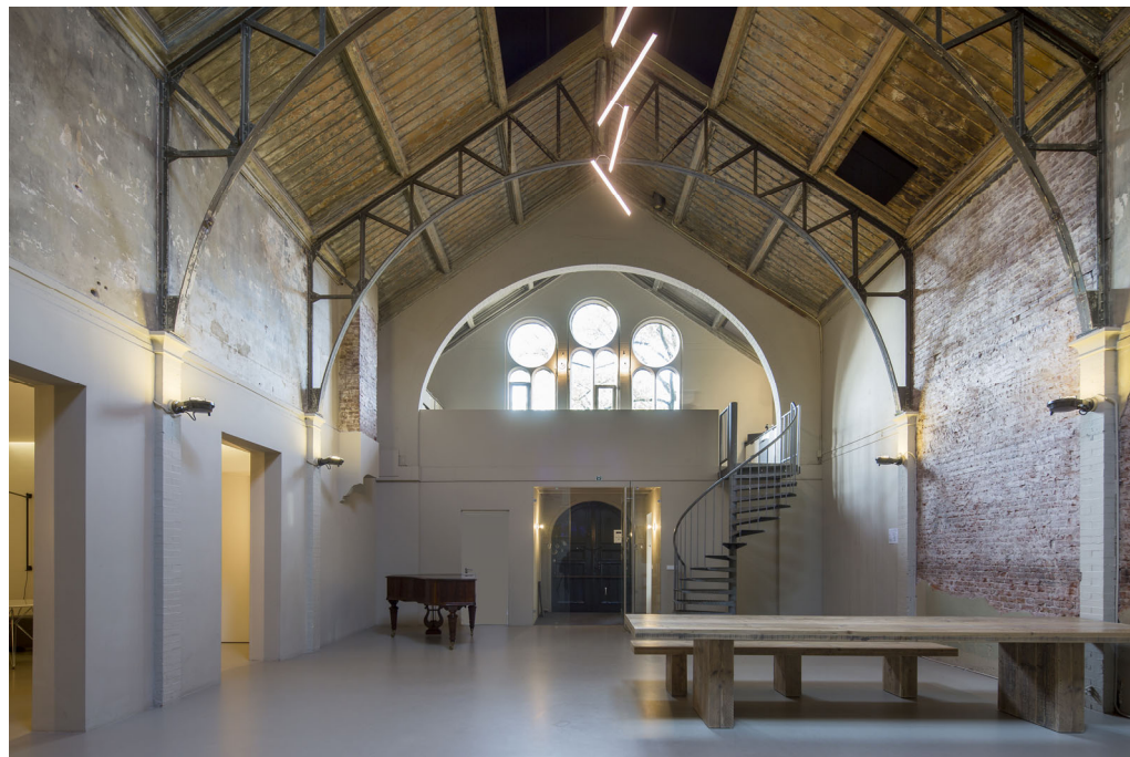
afgekrabt metselwerk bestaande bouw n zicht gecombineerd met moderne ingrepen
